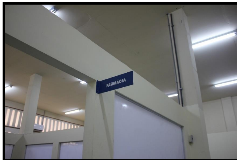
Figura 50 - Salas de atendimento abertas em cima. Fonte: MNPCT.
