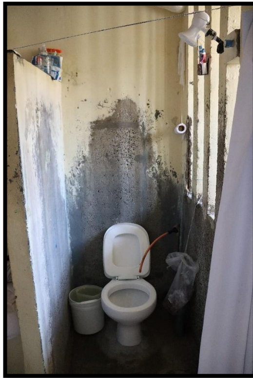
Figura 11 - Sanitário de frente para a ventana. Fonte: MNPCT.
