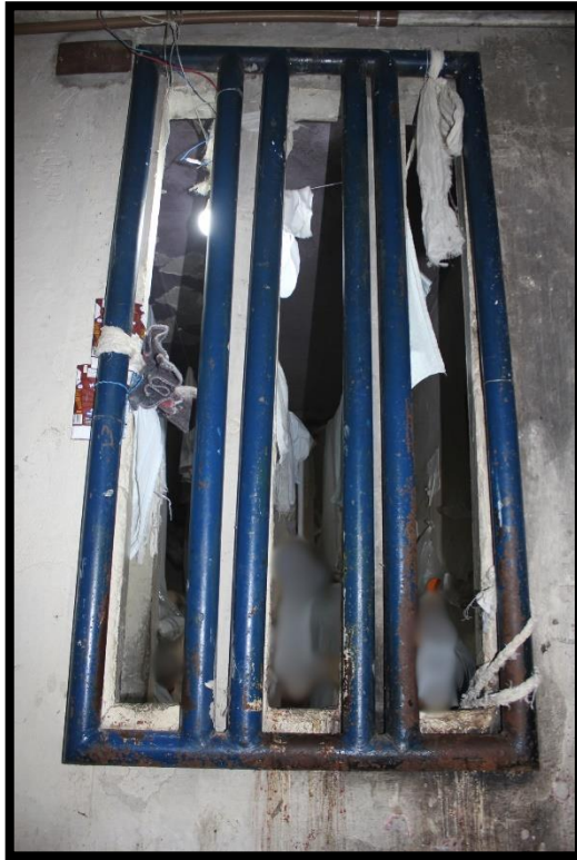
Figura 7 - Ventana da cela de frente para o corredor. Fonte: MNPCT.
